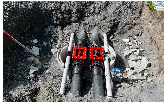
Revisionsklappen Druckleitung Abschnitt Sportplatz–ARA Sargans
