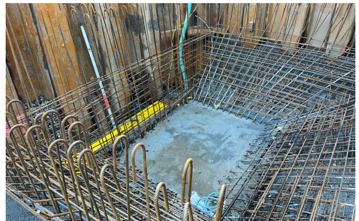
Spundwände und Bodenplatte Pumpensumpf PW Seidenbaum
