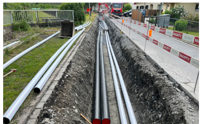
Werkleitungsbau Abschnitt Fährhütte
