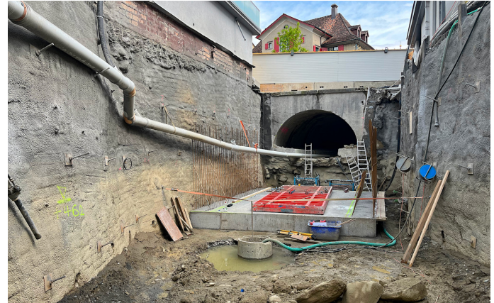
Baugrubensicherung und Bodenplatte, Etappe 1
