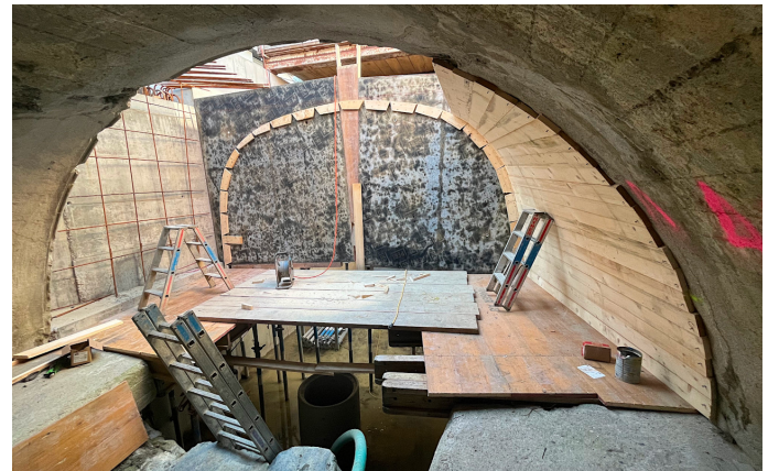
Rundschalung Übergangsbereich zu DL Frauenhoferplatz
