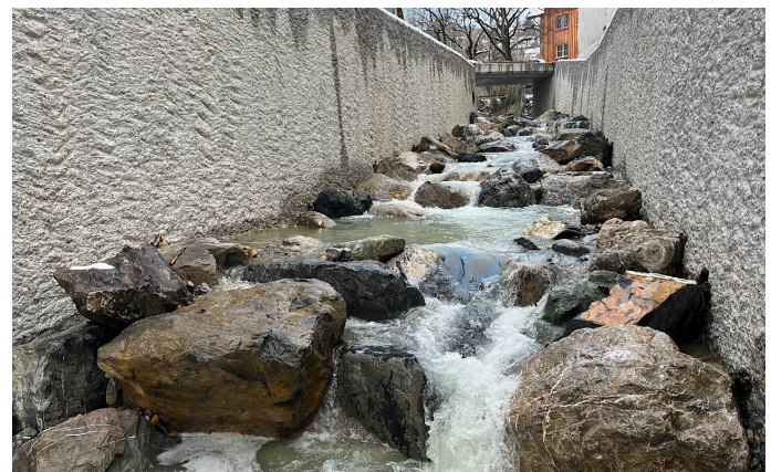
Strukturierte Betonoberfläche und neu eingebaut Kiessohle
