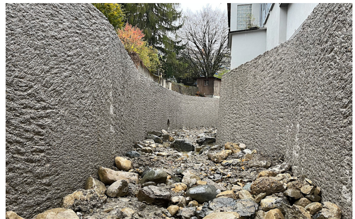
Strukturierte Betonoberfläche und neu eingebaute Kiessohle
