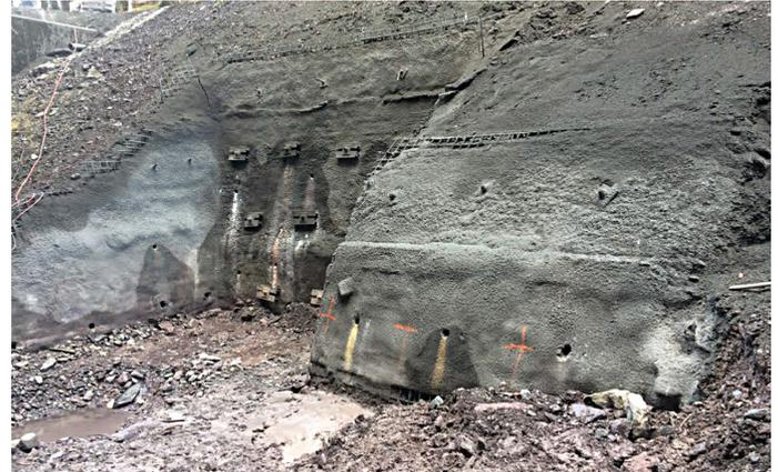
Sicherungsarbeiten mit ungespannten Anker und Spritzbeton
