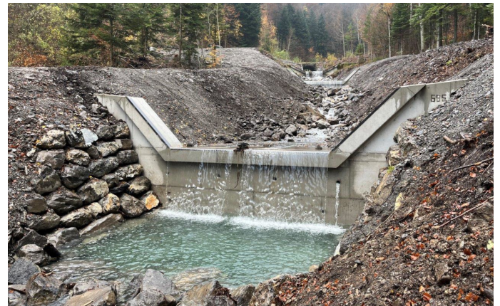
Sperre 685 nach Fertigstellung
