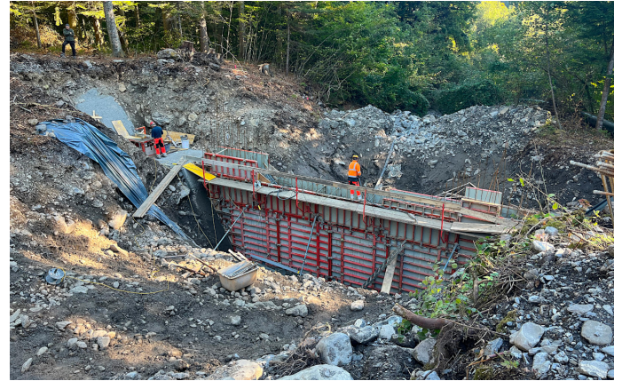
Sperre 685 im Bau
