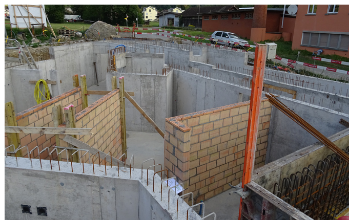
Stahlbeton und Mauerwerk in UG
