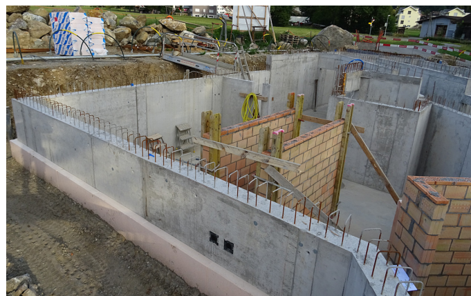
Stahlbeton und Mauerwerk in UG
