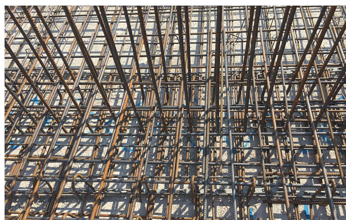
Bewehrung/ Anschlussbewehrung
