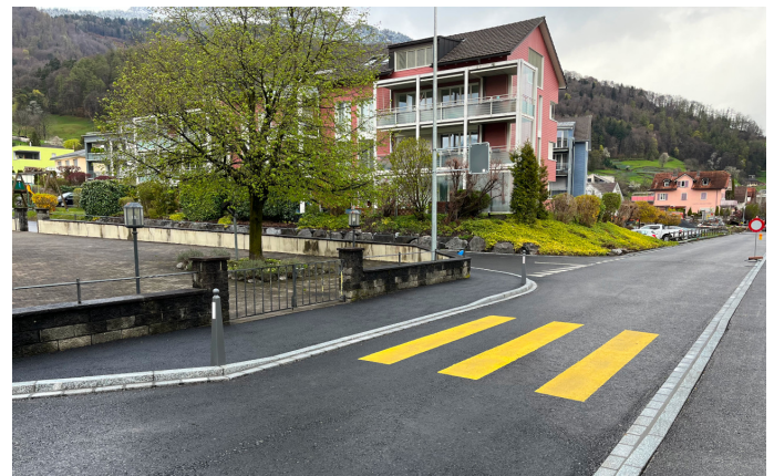
Bereich vor Römisch-Katholischer Kirche, nach Sanierung
