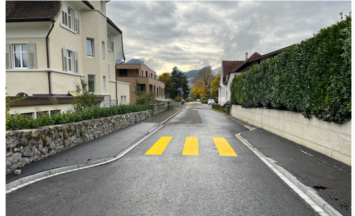
Poststrasse, nach Sanierung
