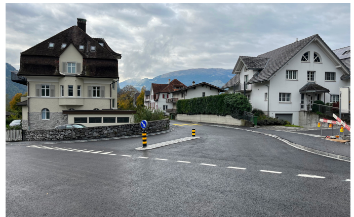
Einmünder Prapafierstrasse, nach Sanierung
